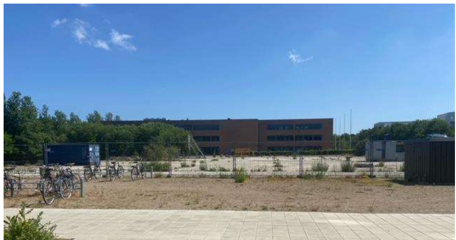
Udsigt over delområde 3, hvor 2. etape af bebyggelsen opføres.
