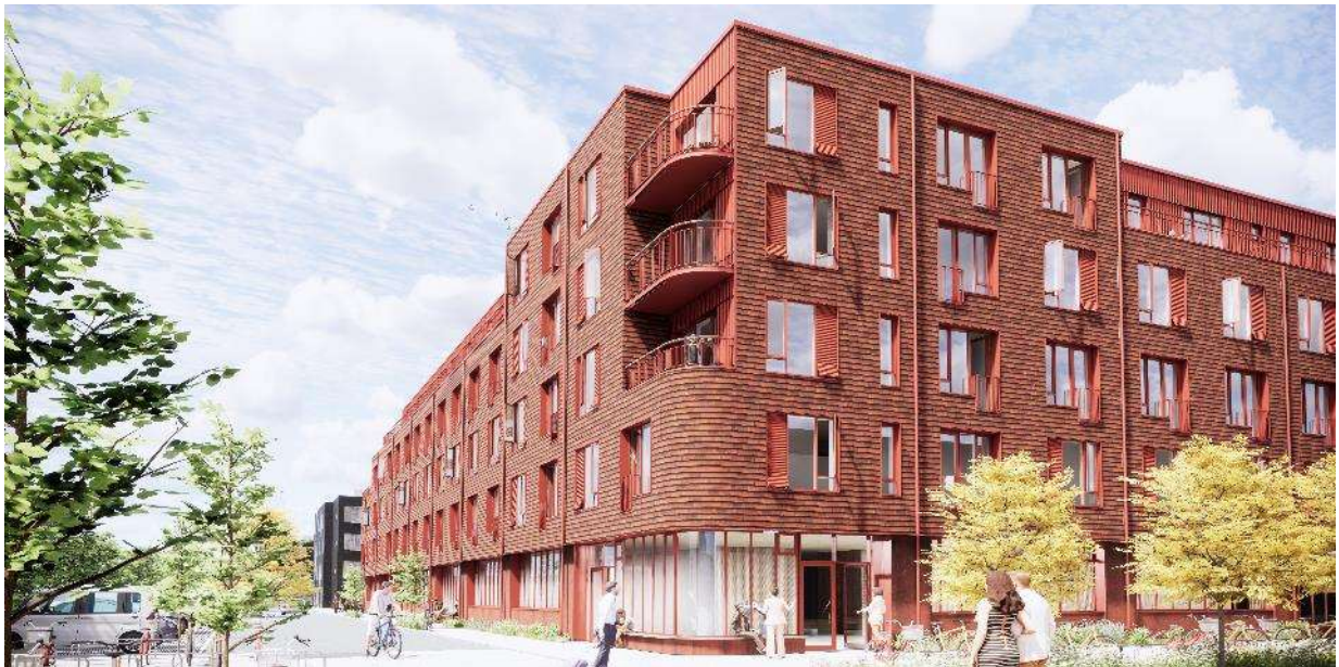
Hjørne mod sydøst / set mod vest ad Lundtoftevej. Hjørnet mod sydøst er markeret dels ved rundet hjørne og de rundede hjørnealtaner (se bilag 2B), og dels ved den teglbeklædte facade over stueetagen. Stueetagen ligger lidt tilbagetrukket og har store vinduespartier, hvor facaden er pudset i en teglrød nuance. De viste træer er 4-5 meter høje på det tidspunkt, hvor bebyggelsen er taget i brug.
