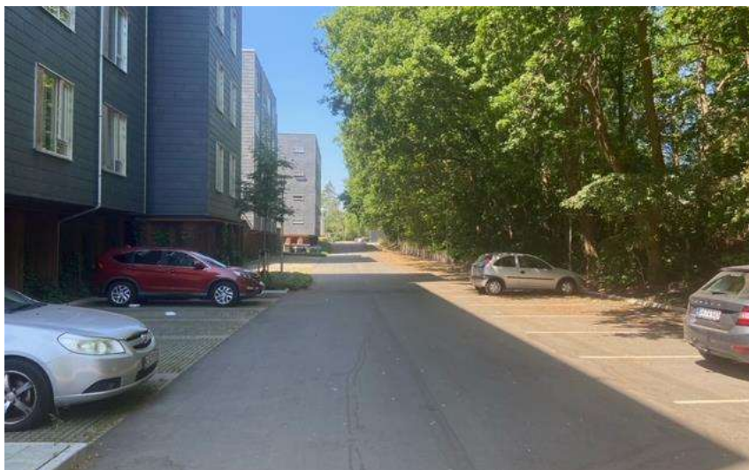
Etape 1 set mod vest fra den interne adgangsvej nord for ungdomsboligbebyggelsen. Der er et terrænspring på ca. 3 m til strædet og adgangsarealer. Th. ses beplantningsbæltet med poppeltræer, der står på Lundtofteparkens ejendom.
