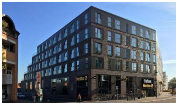
Byggeriet på Lyngby Hovedgade 65 er et eksempel på for høj bebyggelsesprocent.
